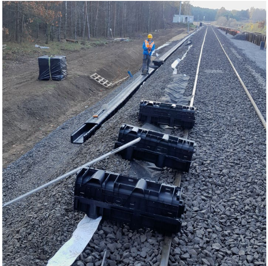
Abb. 1: Anwendung von Kunststoffkabelkanälen auf einer Eisenbahnbaustelle
