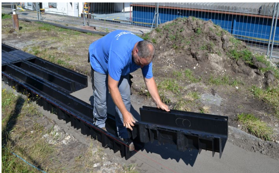
Abb. 4: Der Kunststoffkabelkanal ist ohne schweres Gerät einfach per Hand verlegbar.
